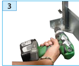
3 Das Geländer an beiden Seiten auf dem Kabinendach montieren, (Blechdicke mini 4mm / M8 Schrauben & Muttern)
